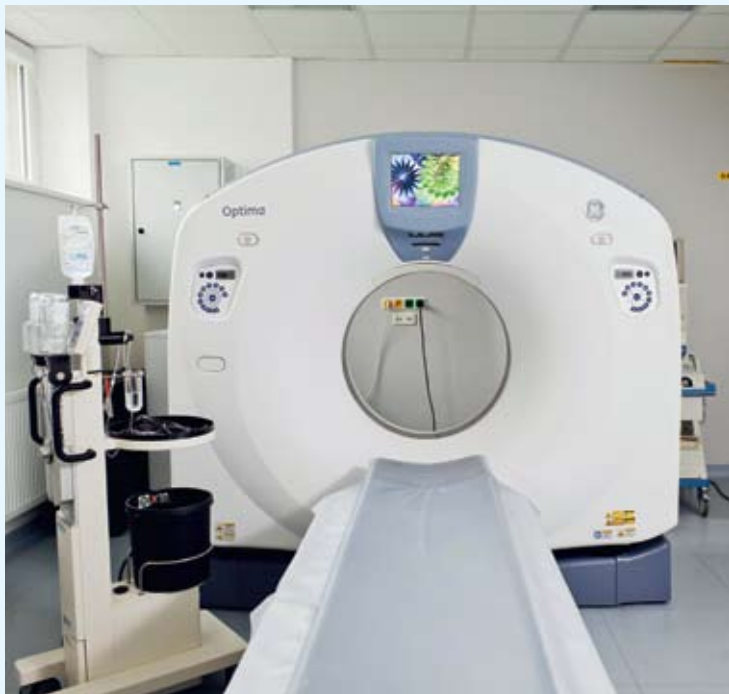
V suterénu polikliniky vzniklo nové oddělení radiodiagnostiky vybavené moderní technikou
