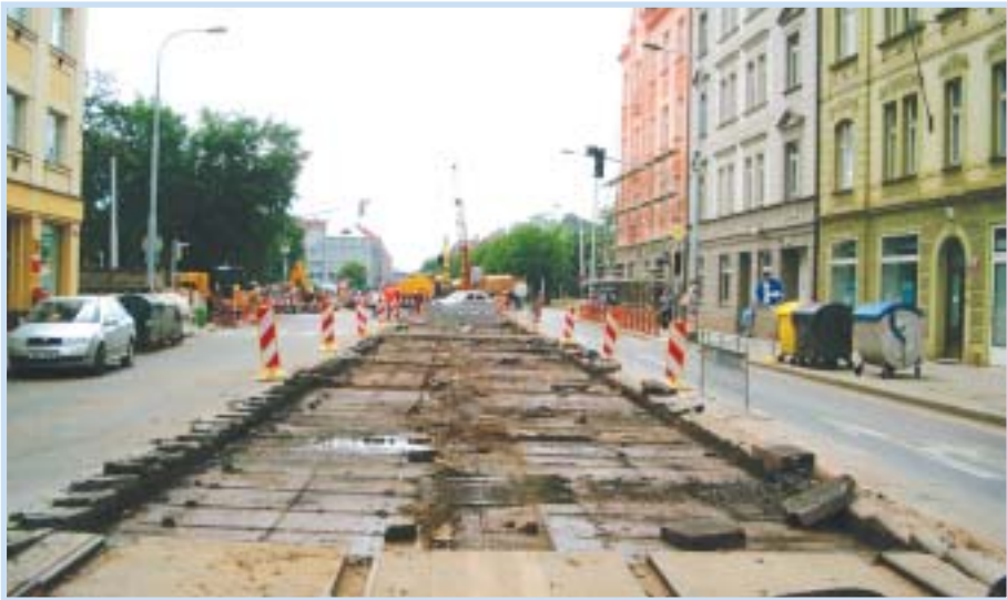
Sokolovská v úseku od Balabenky směrem z centra k metru Vysočanská prochází další etapou rekonstrukce.
