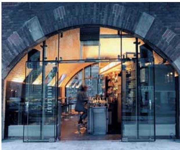
► Při zasklívání oblouků vídeňského viaduktu se musel řešit problém s vibracemi
