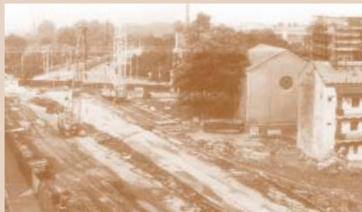
Staveniště hloubené stanice Palmovka na traťovém úseku II. B v roce 1985.
