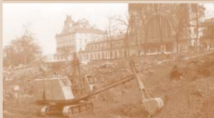
Bagrování stavební jámy pro stanici Hlavní nádraží 17. června 1967.
