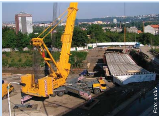
Ukládání nosníků na silničním mostě „malá Palmovka“.
