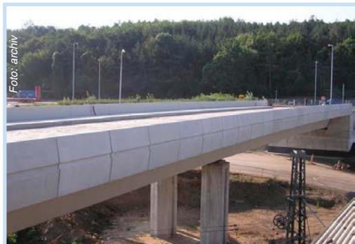
V září dokončená část silniční estakády.
