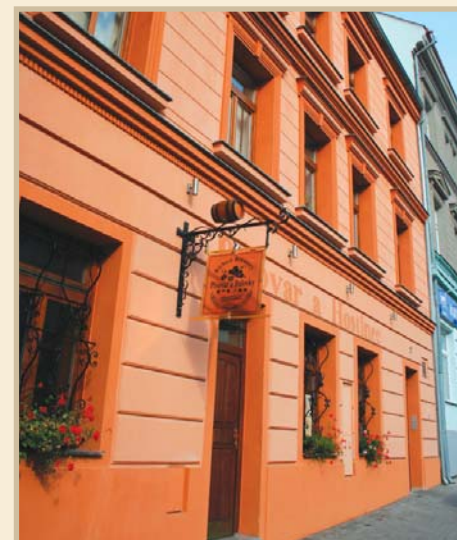
Původní zdemolovaná budova musela být odstraněna, nyní místo ní stojí zcela nová.
