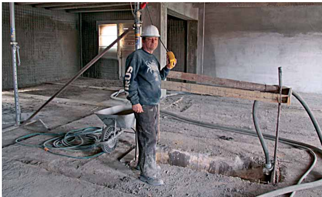
Dělníci začali opravovat například vnitřní omítky objektu
