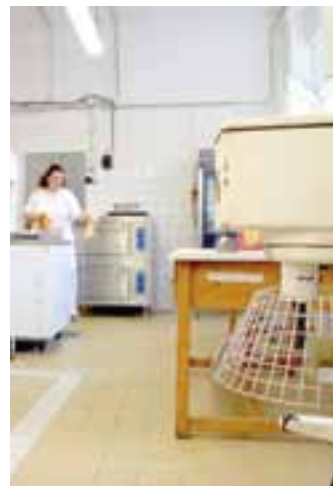
Zařízení kuchyně již neodpovídá požadavkům moderního vaření
