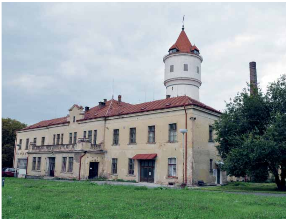
V prostorách prádelny se představí umělci zabývající se institucemi, které nás ovlivňují
