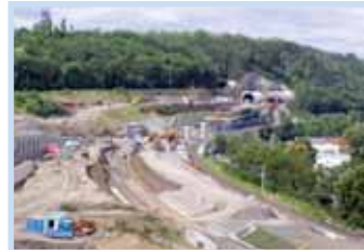
Celkový pohled na výstavbu Nového spojení nad karlínskou lokalitou Sluncová.
