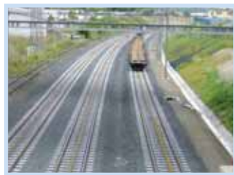
Nové spojení využili stavbaři v minulých týdnech i jako dílnu pro svařování kolejnic určených pro výstavbu železničního koridoru v Beněšově.
