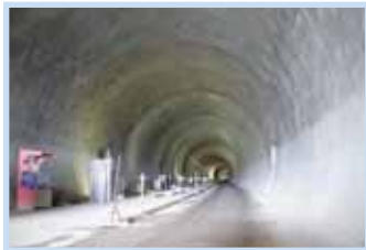
Dokončená část jižního železničního tunelu pod Vítkovem.
