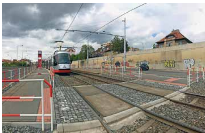
TRAMVAJOVÁ ZASTÁVKA VYCHOVATELNA je zatím bezbariérově přístupná ze severu, ale pracuje se i na jižní straně.
