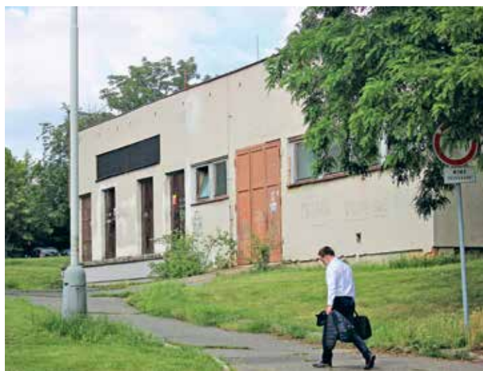
LETITÁ VÝMĚNÍKOVÁ STANICE mezi ulicemi Notečská a Hnězdenská na bohnickém sídlišti.
