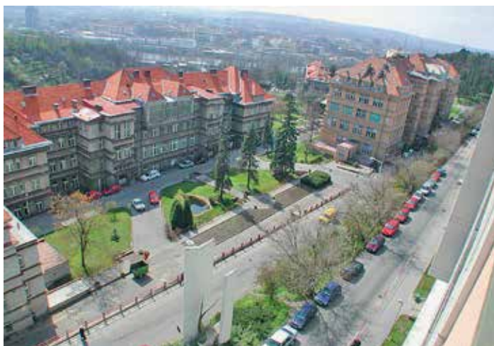
OBJEKTY BULOVKY nejsou v dobrém stavu.
