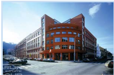
Palác Karlín. Jedním z prvních rekonstruovaných domů v Karlíně byl Palác Karlín v Křížkově ulici.
