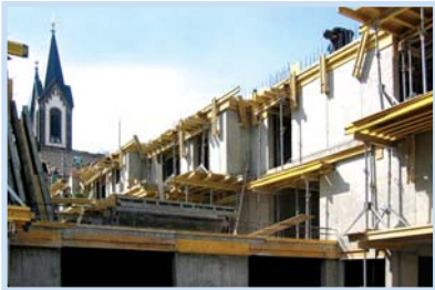
Kollárova. Přestavba původního domu v Kollárově ulici číslo 14 i dostavba nové vnitřní části jsou v plném proudu. První nájemníci se do dvaceti nových bytů budou stěhovat v únoru příštího roku.
