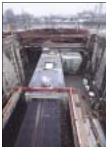
Jednotlivé tunely byly nejprve vybetonovány ve stavební jámě na trojském břehu, která sloužila jako suchý dok, a poté vysunuty do Vltavy.
