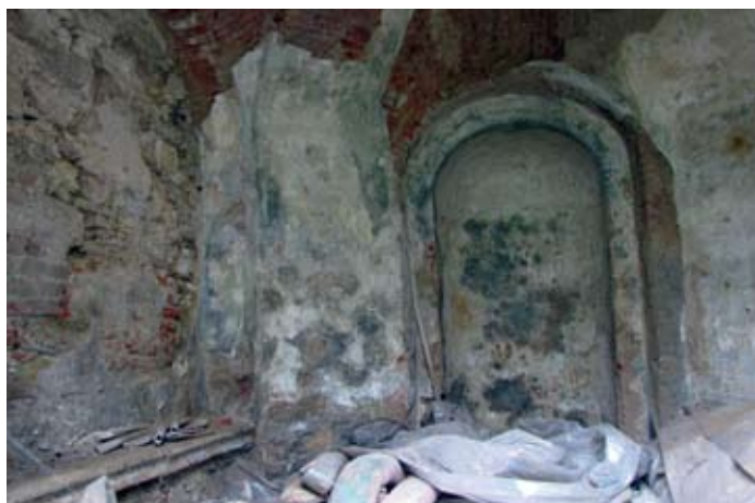
Současný interiér kaple
