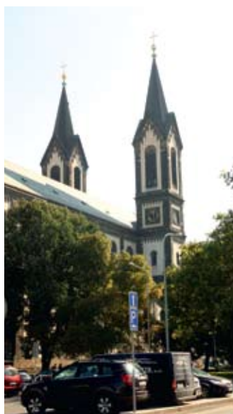
Věže karlínského kostela měří více než 78 metrů
