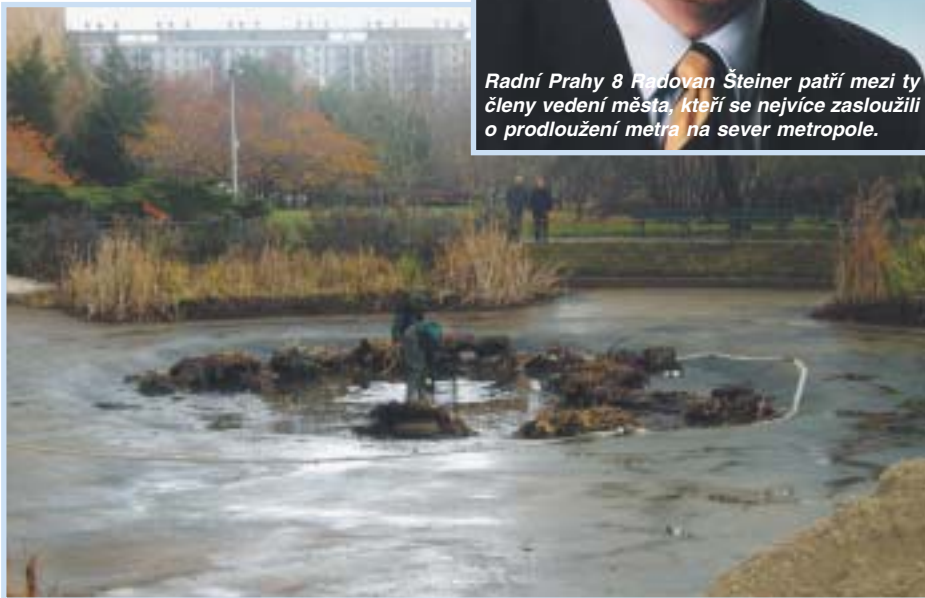
Jezírko v blízkosti stanice metra Ládví prošlo v minulých týdnech opravou, vypustila se voda a vyčistilo se od bahna. Zrušila se již neopravitelná obvodová zídka, kterou nahradily velké kameny. Příští rok se v jezírku objeví vodní rostliny.
