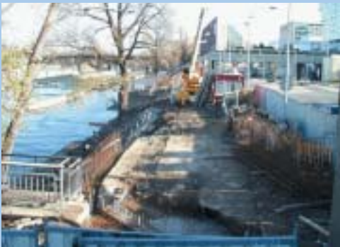
Výstavba protipovodňových zábran pokračuje v těchto dnech naproti hotelu Hilton v úseku Hlávkův most - Negrelliho viadukt i v ústí Rokytky do Vltavy nedaleko Libeňského zámku.
