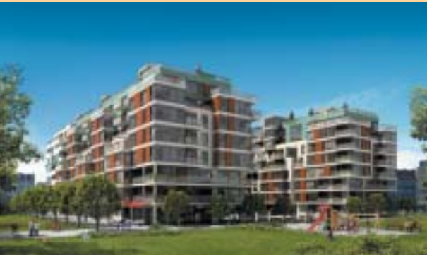
Pohled od břehu Vltavy na nový obytný komplex River Diamond na Rohanském ostrově. V pravé části Nil House ( nyní ve výstavbě ), v pozadí Pobřežní ulice se stávající zástavbou.
