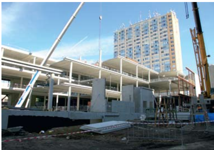
Demolice staré budovy již skončila, nová podoba centra již dostává tvář
