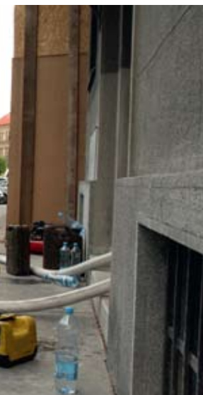
Spodní voda se dostala do sklepů a dvorů i v Chocho-louškové ulici. S jejím vyčerpáním pomohli hasiči
