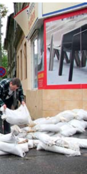
Voda stoupala Koželužskou ulicí směrem k Zenklově. Bylo tedy nutné nasadit tradiční pytle s pískem
