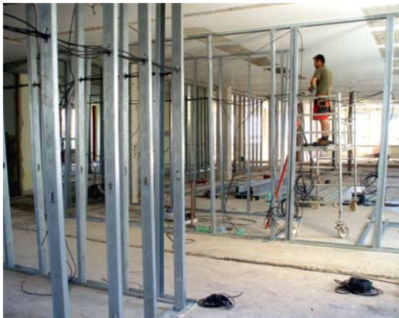
V plném proudu je přestavba prostor na tři nové třídy mateřské školy v Libčické ulici
