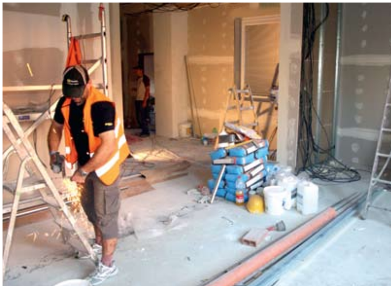
Práce na vybudování nového centra jsou v plném proudu
